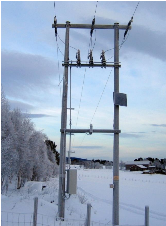
Installasjon i felt
